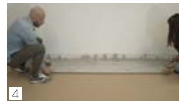
4 Posare il pavimento senza fuga Lay the floor tiles with close joints
