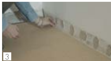
3 Posizionare i distanziali lungo il perimetro Fit the spacers around the outer edge
