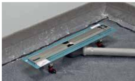
Шаг 1 – Сборка дренажного канала, выравнивание канала по горизонтали с помощью опор, подключение к канализации
