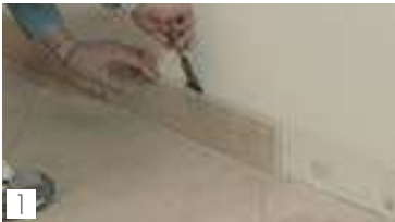
1 Eliminare il battiscopa Remove skirting
