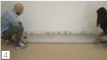
4 Posare il pavimento senza fuga
